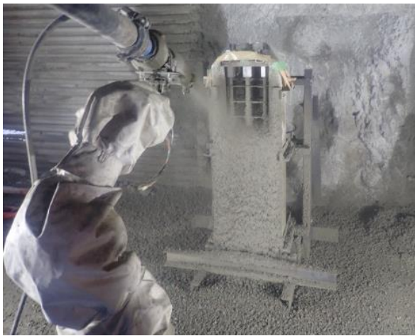
Photo 10 ロボットによる吹付状況 Spraying by Robot
