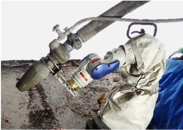
Photo 9 ロボットと吹付ノズル Robot and Spray Nozzle
