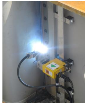
(2) 梁ウェブの立向き溶接
