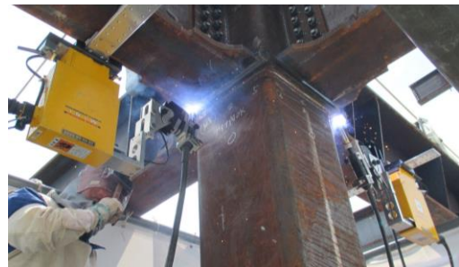
(1) 梁下フランジの上向き溶接
