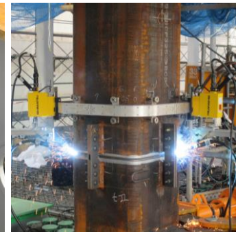
(3) 角形鋼管柱の横向き溶接
