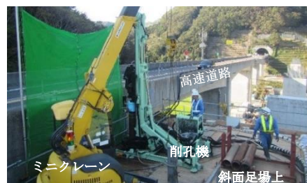
Photo 6 高速道路本線での二重管削孔状況 Double Tube Excavation Nearby Highway
