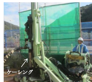
Photo 8 高速道路本線 での二重管削孔状況 Double Tube Excavation Nearby Highway
