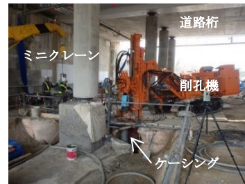
Photo 1 桁下での 二重管削孔状況 Double Tube Excavation Under Girder Space
