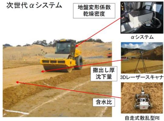
Photo 3 次世代  $\alpha$  システムの機器構成
