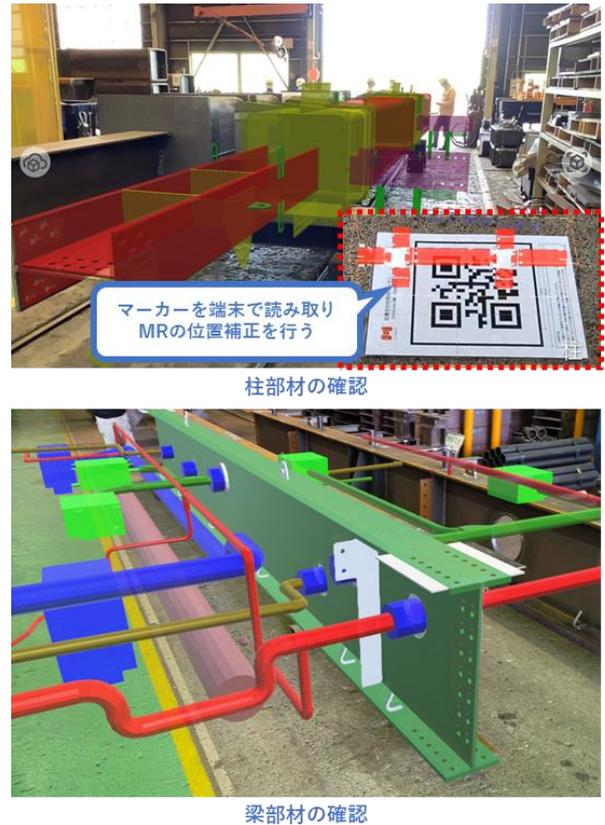
Photo 3 鉄骨製品検査への適用事例
