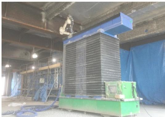
Photo 1 耐火被覆吹付けロボット
