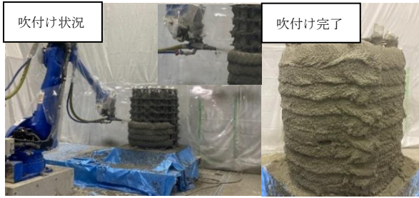
Photo 3 ロボットアームによる吹付け状況 Spraying by Robot Arm
