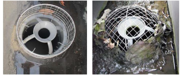
(a)筒型ストレーナー (b)ドーム型ストレーナー
