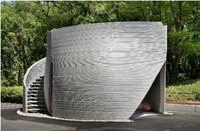
Fig. 5 3D プリンターによる建築物「3dpod™」 Building (3dpod™) Constructed by 3D Construction Printer
