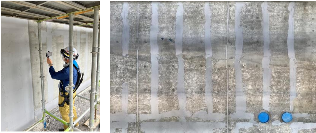
Photo 6 外壁タイルの下地補修記録手法「ヘキレキ™」 Recording Method “Hekireki” for Subsurface Repaired Area in Exterior Wall Tile
