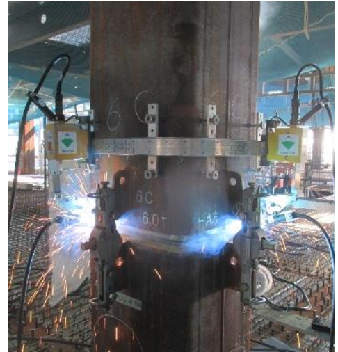
Photo 5 現場横向ロボット溶接工法 Site Horizontal Robot Welding Method
