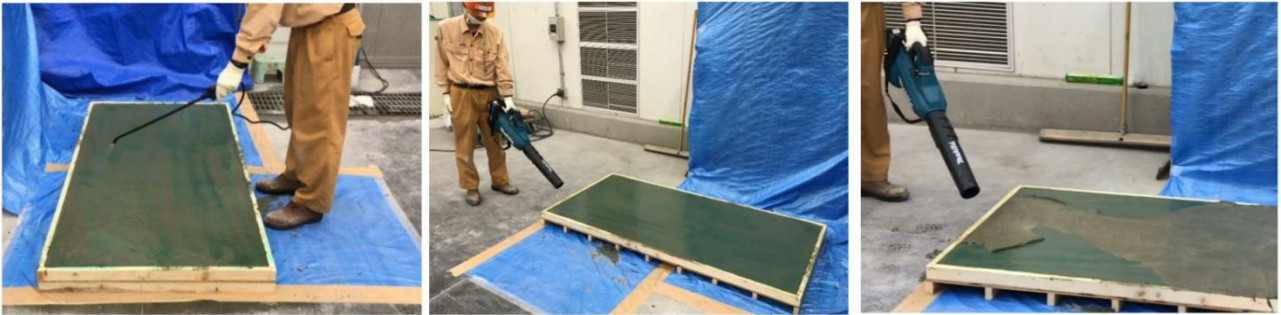
Photo 3 アルギン酸ナトリウム水溶液の散布状況（左）と生成した不溶性ゲルのブローによる除去状況（中，右） Situation of Applying Sodium Alginate Solution and Removing Insoluble Gel
