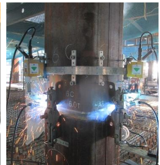
(3) 角形鋼管柱の横向溶接
