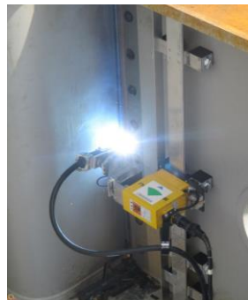
(2) 梁ウェブの立向溶接
