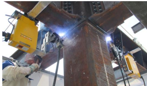
(1) 梁下フランジの上向溶接
