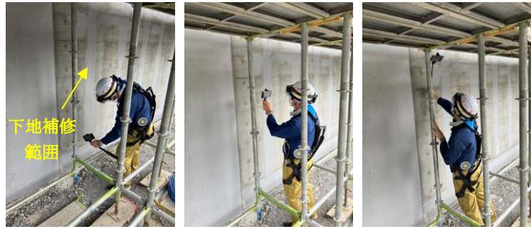
Photo 1 ヘキレキの作業状況 Construction Status of Hekireki
