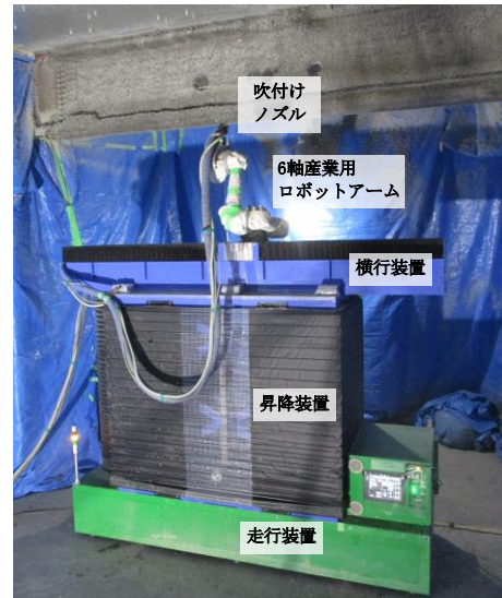
Photo 2 耐火被覆吹付けロボット Fireproof Coating Spraying Robot
