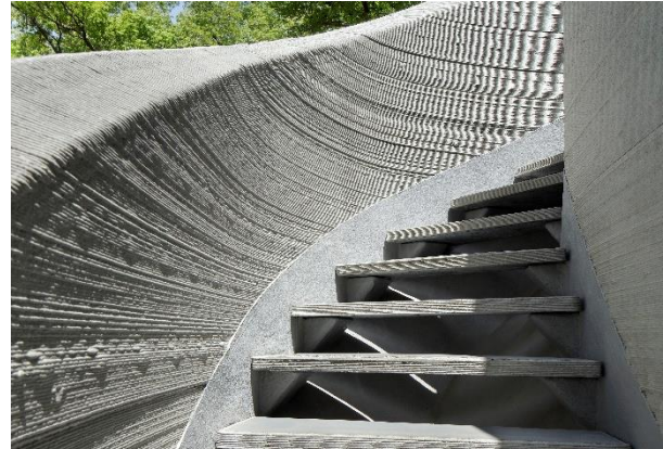
Fig. 21 外部階段のプリント Printing of Exterior Staircase
