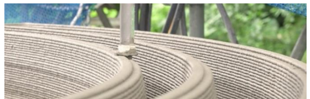
Fig. 19 複層壁のプリント Printing Multilayer Walls
