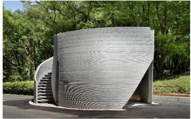
Fig. 23 完成状況 (外観) Completion(External View)
