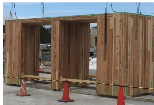
Photo 1 CLTユニット CLT Unit
