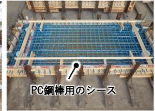
Photo 8 PC床版におけるコンクリート打設前の状況
