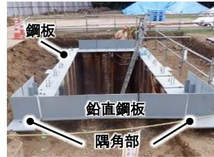
Photo 7 鋼矢板への鋼板設置状況
