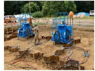
Photo 2 鋼矢板根固め状況
