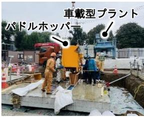
Photo 11 スリムクリート打設状況
