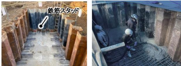
Photo 5 鉄筋スタッド完了 Completion of Reinforcing Steel Stud
