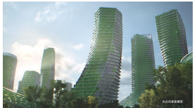
Fig. 7 光合成燃料電池パネルを搭載したビルの例 9) Buildings Having Photosynthetic Facade
