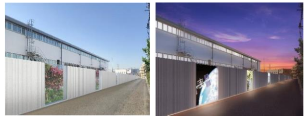
(1) アクリルパネル (2) ライトアップ Fig. 8 景観配慮型の防水壁 Examples of Landscape Friendly Flood Wall
