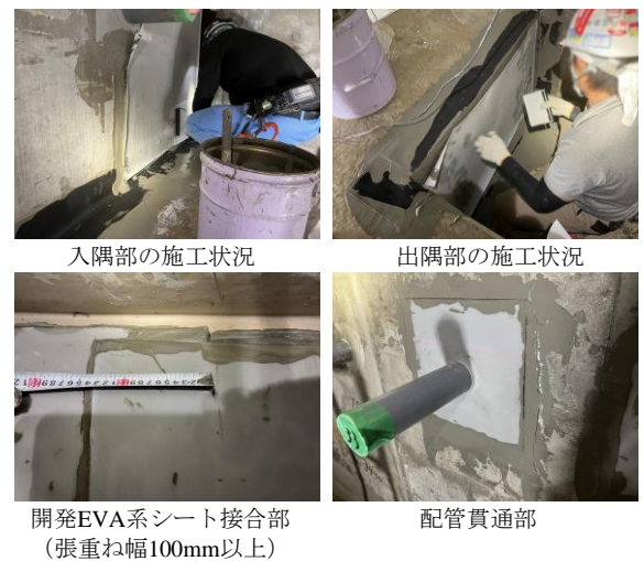
Photo 4 インナーシャットの納まり Fit of Inner-Shut
