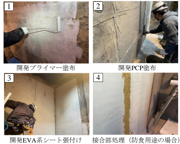
Photo 3 インナーシャットの施工手順 Construction Procedure for Inner-Shut
