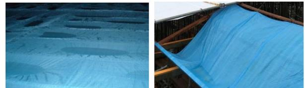
Photo 1 ブルーシートによる降雨対策の事例
