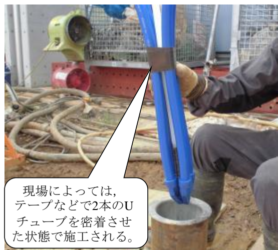
Photo 2 2本のUチューブが密着状態となるイメージ Image of Two U-Tubes in Close Contact
