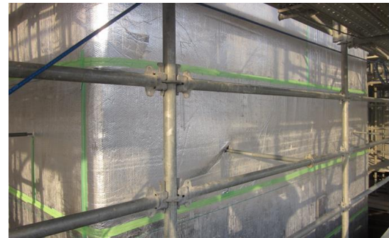
Photo 2 アクアサーモの施工事例（橋脚） Construction Example of Aqua Thermo (Bridge Pier)
