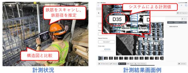
Fig. 9 鉄筋径の計測状況
