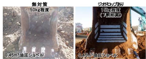
Photo 3 1時間掘削作業後のバケット内の付着状況
