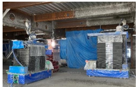
Photo 5 ロボット2号機の施工状況 Construction Status of Gen2 Robot
