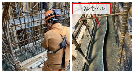
Photo 5 散布状況と散布後のコンクリート表面 Spraying Situation and Concrete Surface after Spraying
