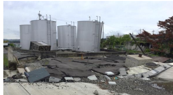
Photo 1 沿岸部における液状化被害の例 Example of Liquefaction Damage in Coastal Area
