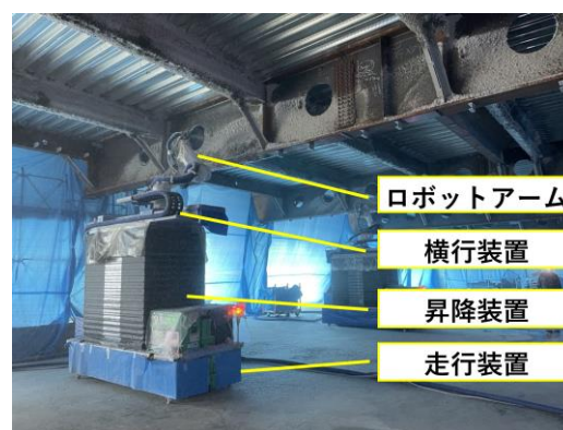
Fig. 1 耐火被覆吹付けロボット Fireproof Coating Spraying Robot
