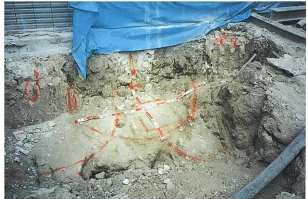
Photo 2 コンクリート固結体造成状態 Soil Improvement
