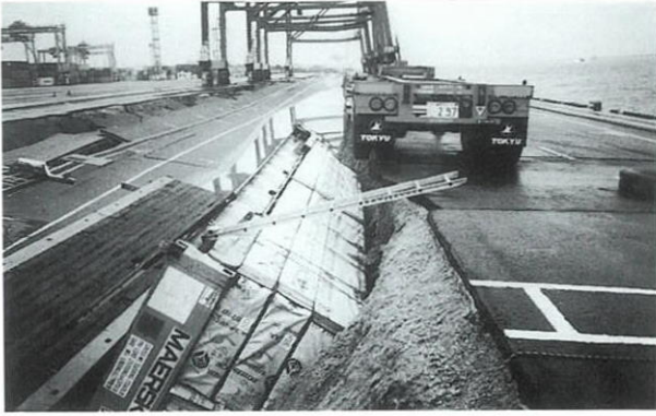
Photo 5 被災状況 (R.I.C4 パース) Damage to Quaywall (No. 3) (財団法人神戸港埠頭公社写真提供)
