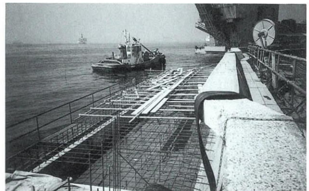
Photo 4 復旧状況（東部第4工区） Restoration Work (No. 2)
