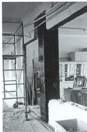
Photo 9-1 炭素繊維シートを巻いた柱 Jacketing by CF Sheets
