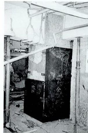
Photo 8 鉄板巻による補強 Jacketing by Steel Plate
