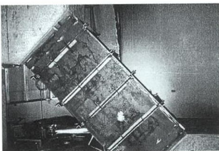
Photo 3-2 鉄板巻（ステップ6） Jacking by Steel Plate (Step 6)
