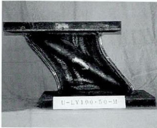
Photo 10 Y形ブレースのリンク材のせん断変形 Shearing of Link Member of Y-Shaped Brace
