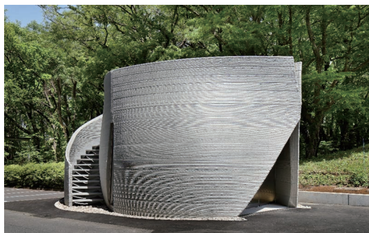
3D プリンターを用いた建築物「3dpod™」 Building (3dpod™) Constructed by 3D Construction Printer
