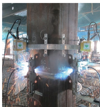
現場横方向ロボット溶接工法 Site Horizontal Robot Welding Method
