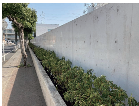
カーボンネガティブを達成した RC 壁 RC Walling with Carbon Negative Concrete
