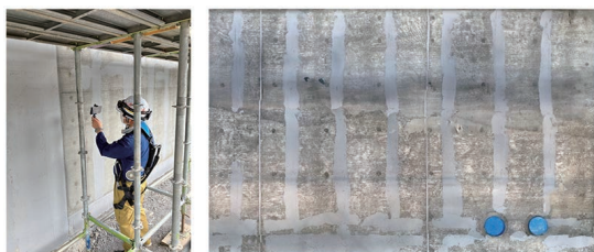
外壁タイルの下地補修記録手法「ヘキレキ™」 Recording Method "Hekireki" for Subsurface Repaired Area in Exterior Wall Tile
