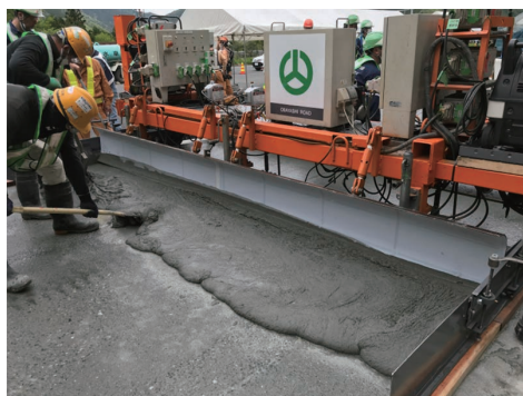
スティフクリート®による上面増厚の施工状況 Construction Status of "Stiff-Crete"
