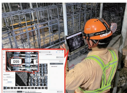
システムを用いた鉄筋径の計測状況 Measurement Status of Reinforcing Bar Diameter Using the System
