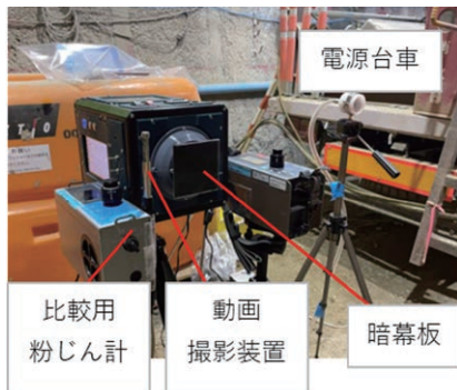
トンネル現場測定状況 Measurement Status of Tunnel Site
