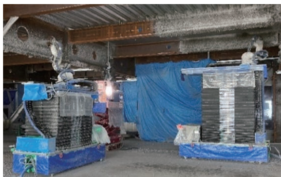
ロボット 2台での施工状況 Construction using Two Robots
