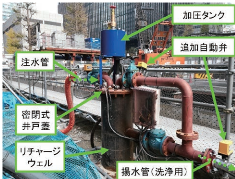
開発工法により加圧注水を併用したリチャージウェル Recharge Well using Pressurizing Method
